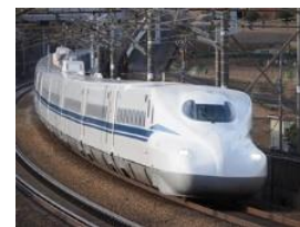
鉄道架線・電線など インフラ設備
