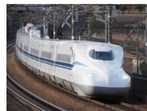
鉄道架線・電線など インフラ設備
